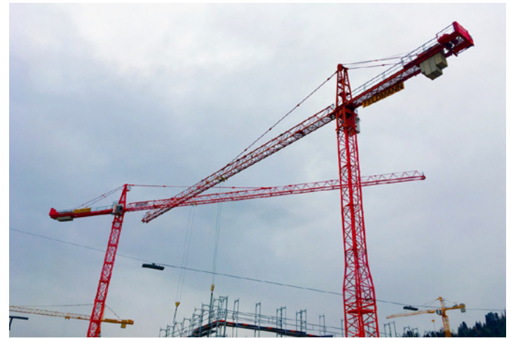
Kranen beim Bahnhof Wattwil: Bauen heisst an der Zukunft bauen.
